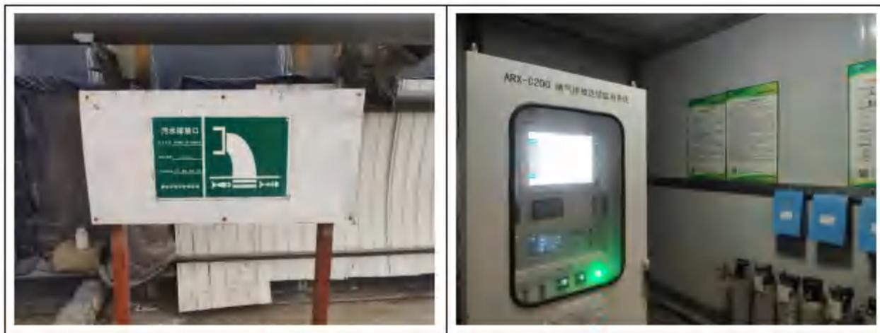
图 4-3 废水采样点及在线监测设备
